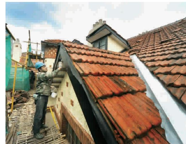
位于复兴中路1363弄的克菜门公寓在进行拆除周边违法建筑的同时,也对主体建筑整体进行了修缮。克菜门公寓外墙砖砌图案为几何图案,既有西方传统特点,又有现代装饰意味。工程修旧如故,重现了这幢法式老洋房的历史风貌。 杨建正 摄
