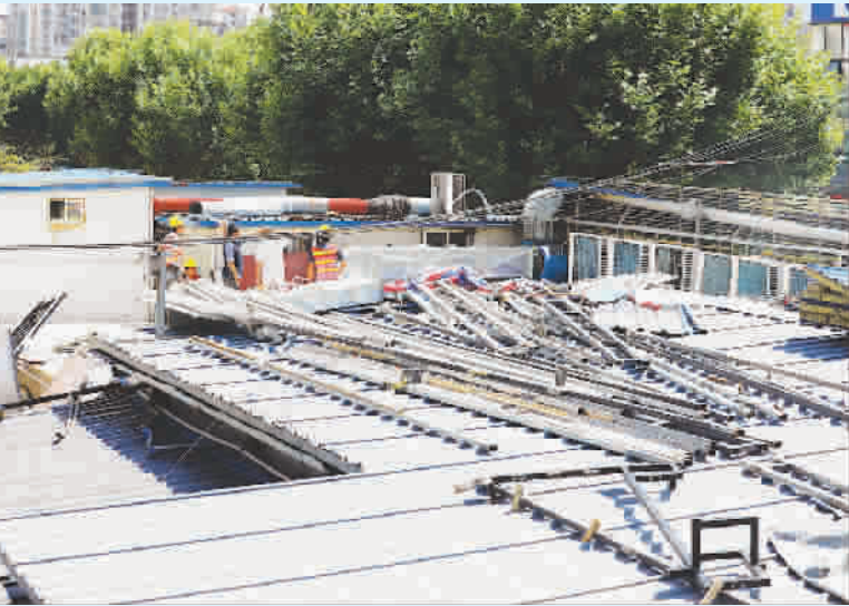
■ 小区内沿街餐饮商铺加盖的二层楼违法建筑正被陆续拆除 见习记者 王凯 摄
