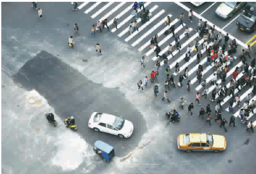
今天凌晨, 恒丰路路面坍塌处已修补完成
