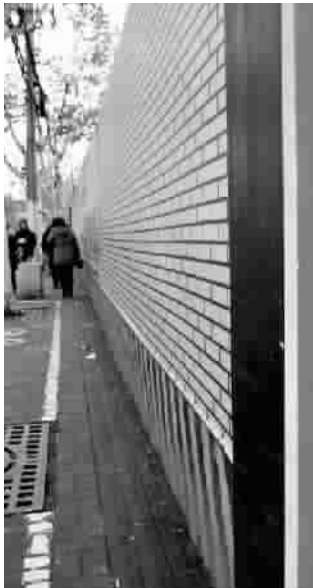
围墙压住部分盲道 网友供图
