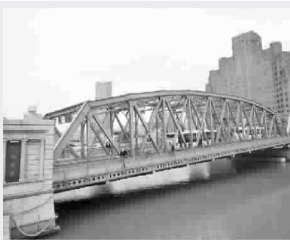
苏州河上真正意义上的桥梁,始建于十九世纪末,即连通当时英美租界的苏州河口的“威尔斯桥”。原先此桥为木结构,二十世纪 20 年代在其侧另建钢结构大桥,即著名的“外白渡桥”(见上图)。
