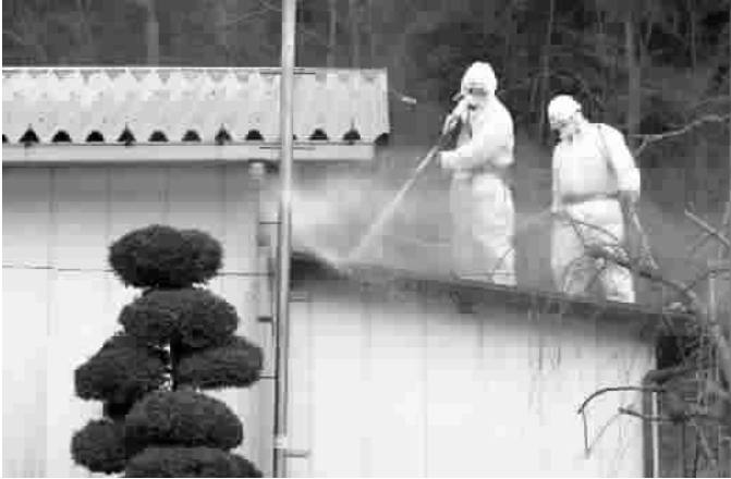
■ 工作人员在被辐射污染的仓库屋顶上喷洒药剂
