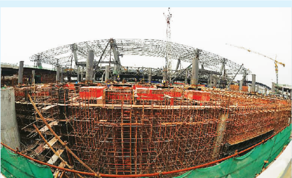
杭州建浙江最大铁路枢纽工程
