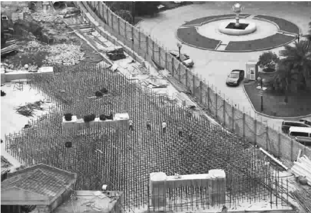
新江宁路桥桥墩现雏形 年底有望竣工通车
