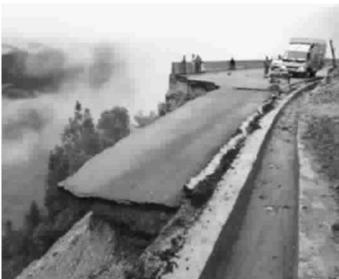
■ 坍塌公路事发现场
