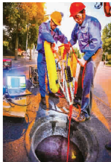
■ 定期对下水道作声呐探测确保畅通
