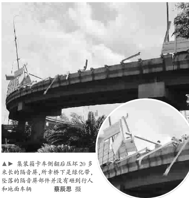
▲ 集装箱卡车侧翻后压坏20多米长的隔音屏,所幸桥下是绿化带,坠落的隔音屏部件并没有砸到行人和地面车辆
