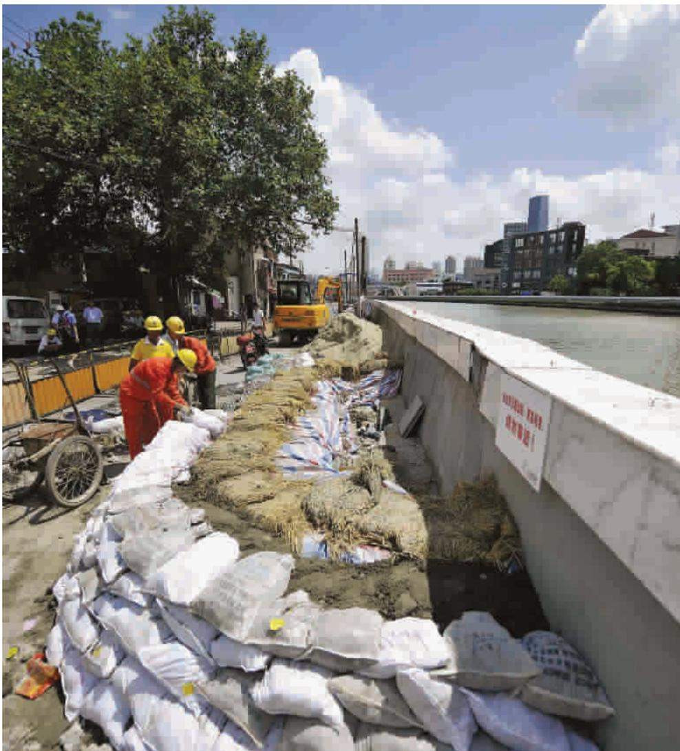
台风“布拉万”逼近,今天上午,上海市水利工程集团有限公司的工作人员利用泥袋在先前光复西路枣阳路段的苏州河防汛墙渗水点外围筑起堤坝,以防河水渗漏。
