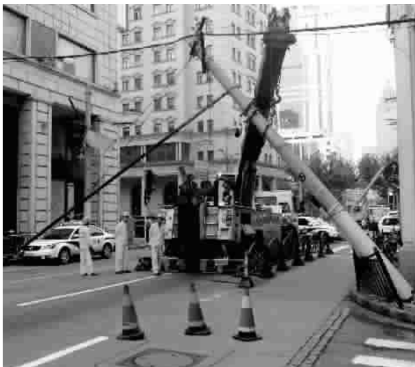
抢修 ■ 电线杆倾斜,大量电线垂在半空,工程抢险人员正在曹文清摄
