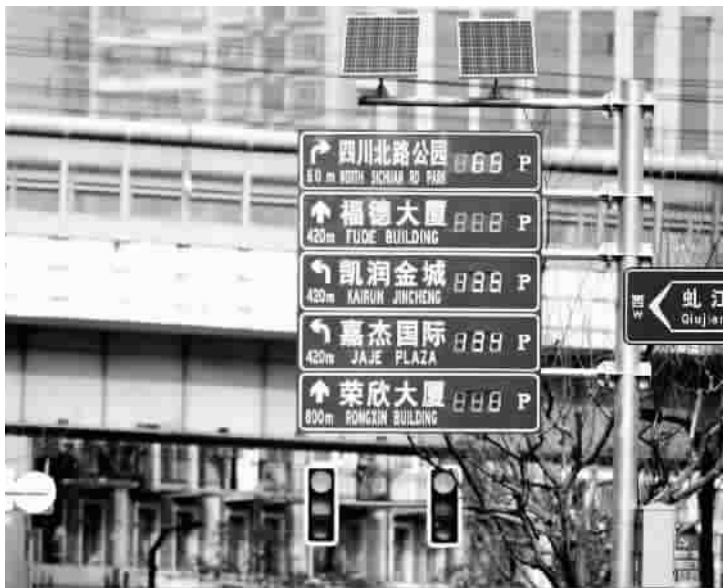
■ 四川北路虬江路口的指示牌还同时显示四川北路周边主要车库的信息 见习记者 陈梦泽 摄
