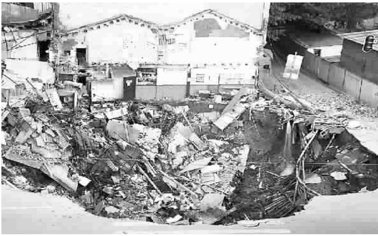
■ 地陷大坑深约10米,面积约100平方米,两栋连着的楼房坠入大坑 图 CFP
