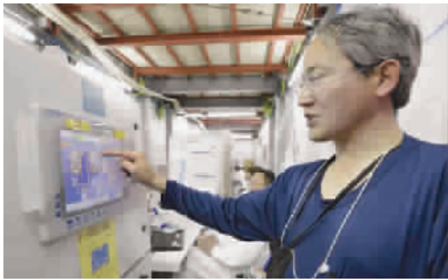
■ 日核电站人员介绍污水处理装置 图 2
