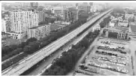
▲ 爆破前拍摄的高架桥
