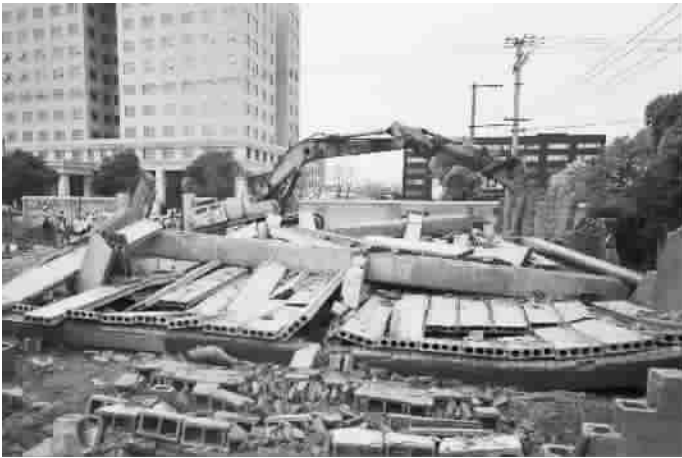
■ 执法人员动用挖土机拆除违法建筑
