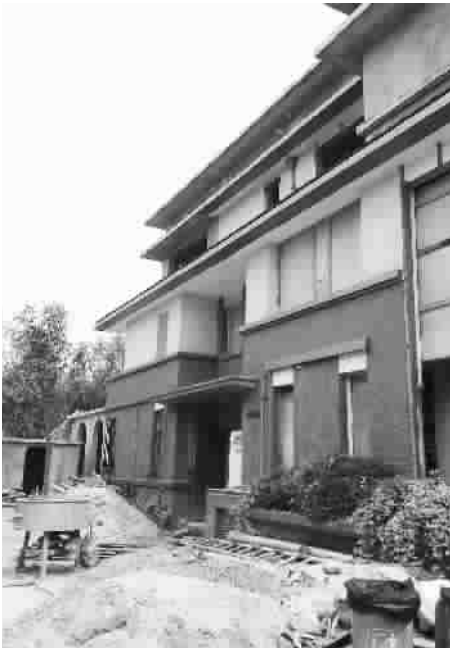
梧桐城邦三期业主正大兴土木 曹文清 摄
