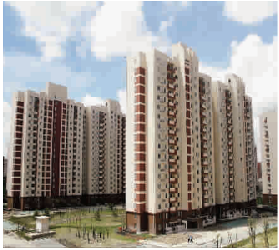
▲ 上海建工房产有限公司开发的 150 万平方米的周康航大型居住社区自 2009 年开工以来,首批面积约 10 万平方米的 1333 套经济适用房已经接待来自黄浦、杨浦、闸北、浦东新区四个区 3300 余户家庭看房,首期农民回迁房 16 万平方米即将交房。图为周康航大型居住社区农民回迁房 A 地块
