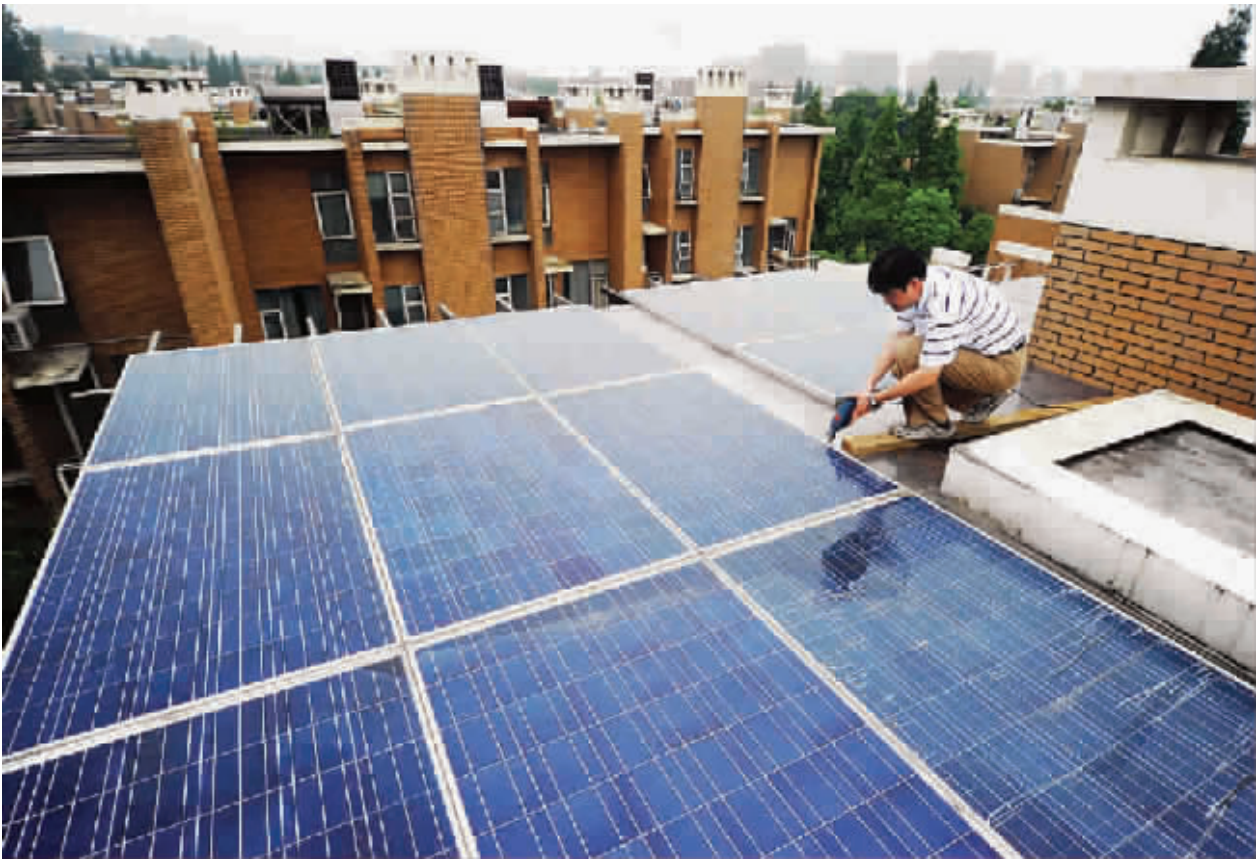
■ 陈继霖在自家屋顶上安装了11块光伏电磁板
