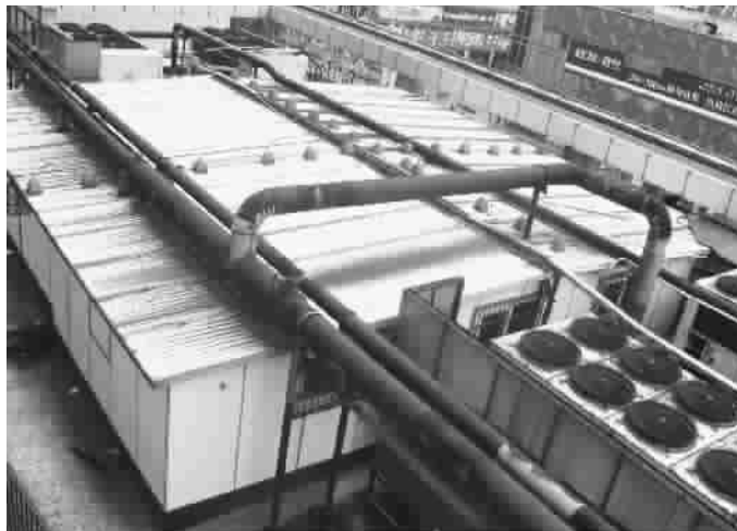
屋顶彩钢板建筑面积相当大,周围管道纵横
