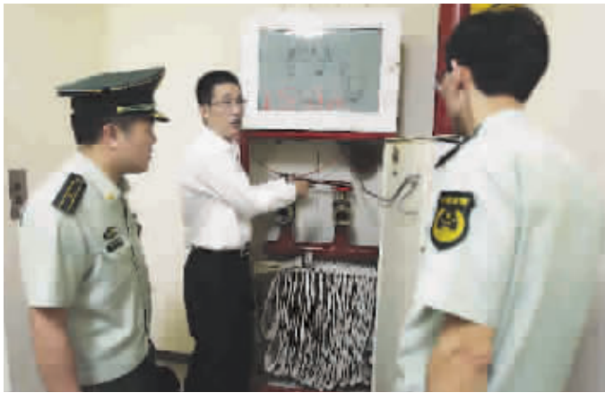
消防人员正在检查餐厅消防设施
