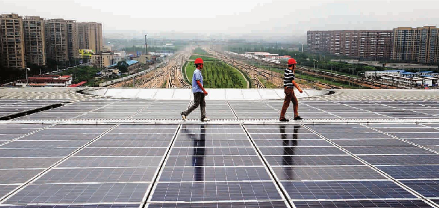
2013年6月29日，安装光伏组件44000块的单体建筑光伏发电项目——杭州火车站屋顶光伏正式并网发电
