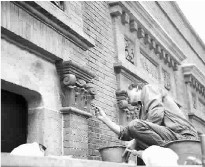
中共二大旧址纪念馆的石库门立面正在进行全面整修，修复人员不仅为外墙砖修饰涂刷，并为部分因年久破损的花式浮雕进行修补还原。这一“修旧如旧”的工程将于月底结束。 肖健 摄
