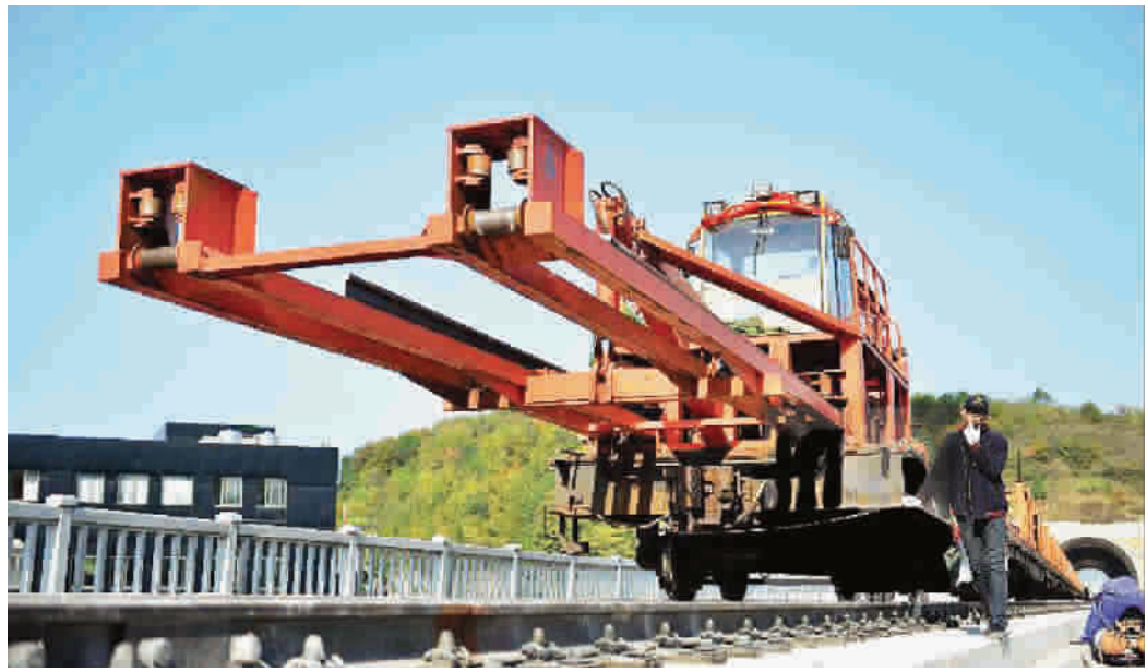
杭长客专攻坚冲刺 杭长客专是杭州到长沙的高速客运铁路专线,设计时速350公里,预计2014年底建成通车,目前铺轨已进入攻坚冲刺阶段。 郝同前 摄影报道
