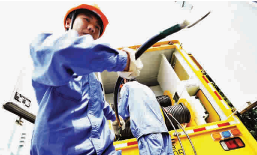
■ 电力职工正在抢修中
