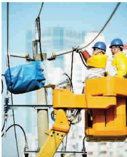
■ 浦东供电公司员工检查改造高架线
