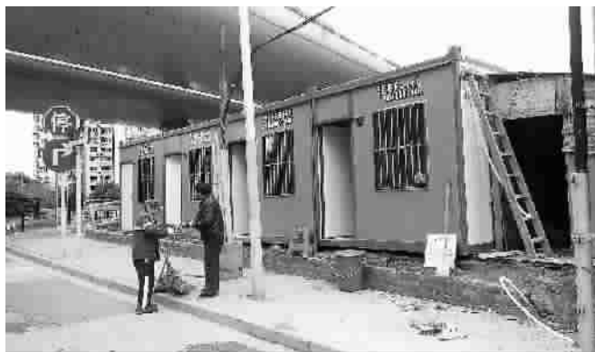
绿化带中四间板房一字排开 陈浩摄
