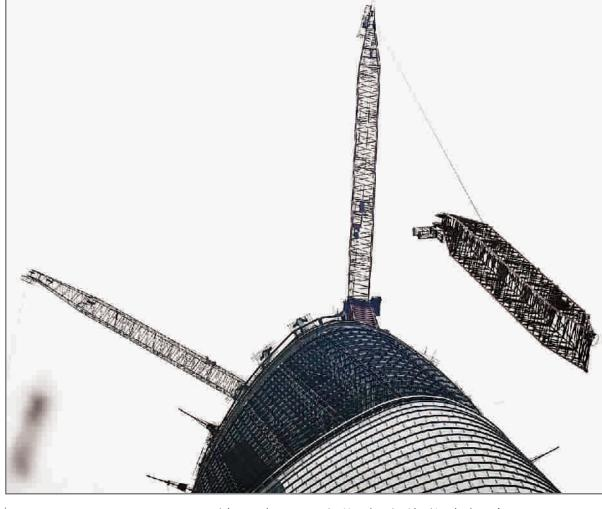
上海中心大厦 顶部4台2450吨・米 塔吊将于本月中下 旬全部拆除。昨天 中午12时,市机械 施工集团有限公司 数十名员工来到上 海中心楼顶, 开始 分解拆除第三台 2450吨·米塔吊,预 计将在3天内完成。
