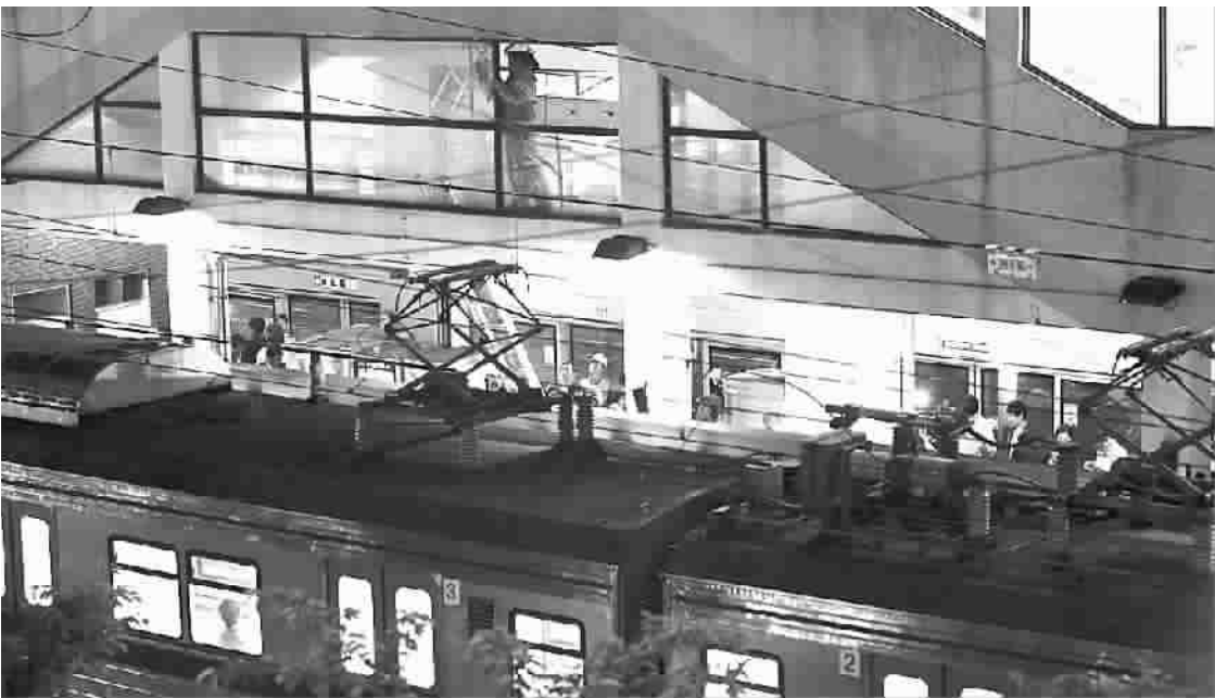
工程人员抢修事故列车
