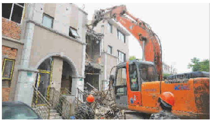
■ 挖掘机在拆除违法搭建
