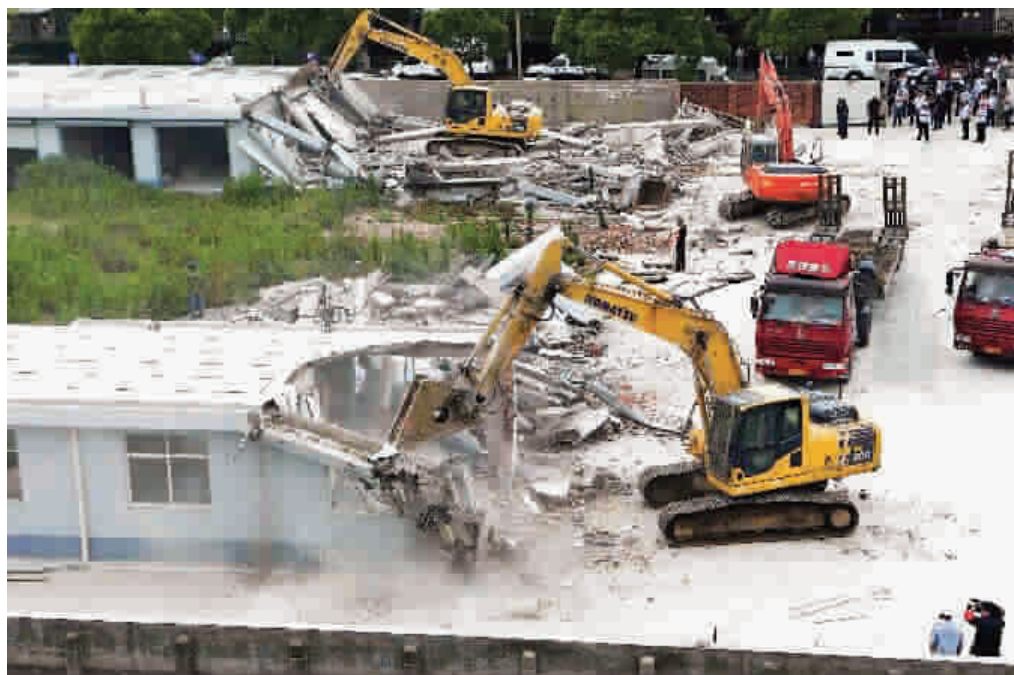
■ 浦东新区祝桥镇对上海玖港果蔬专业合作社进行联合执法，强制拆除10幢违法建筑
