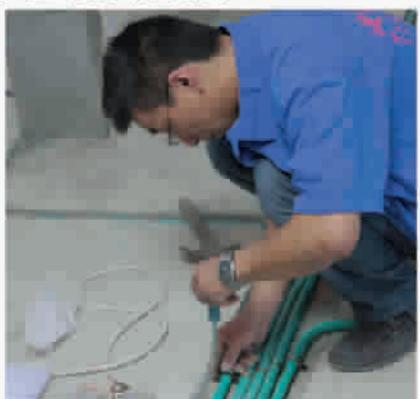
俯身地坪的这位师傅，执行的是波涛自成一格的从难从严施工工艺——“所有线管、水管必须用管卡固定”，且“管卡距离为80cm，弯头处固定距离为15cm”。
