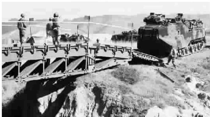
美军工兵部队演练架设桥梁以便两栖突击车跨越深沟
