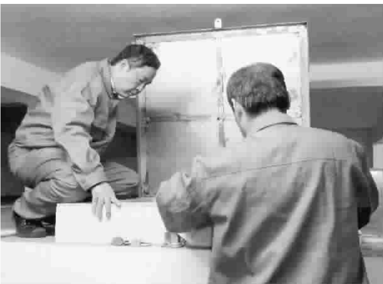
■ 城投水务的工作人员正在查勘已废弃的水箱 本报记者 陈梦泽 摄
