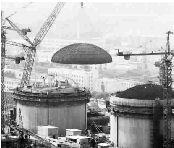
2011年5月27日,方家山核电工程2号机组安全壳穹顶吊装
