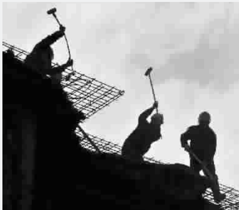
工人正在拆除违法搭建 记者 孙中钦 摄
