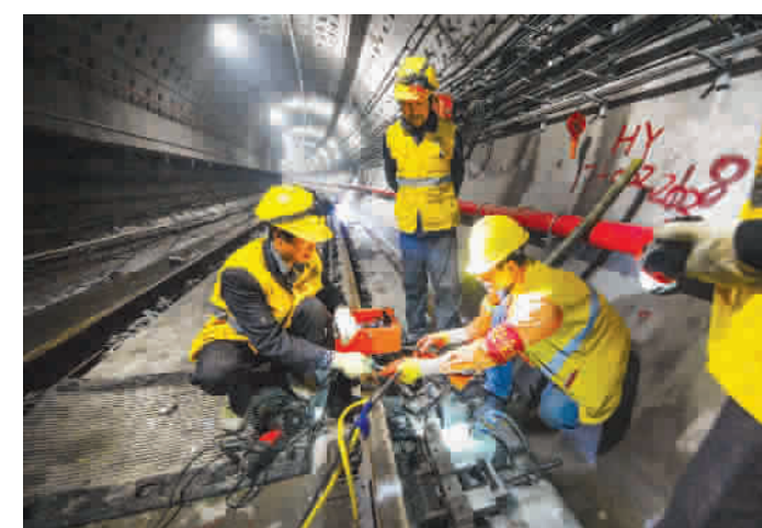
■ 轨交13号线淮海中路站正在加紧建设 本报记者 陈梦泽 摄
