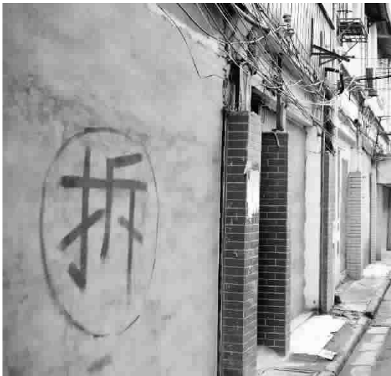
■ 金陵路骑楼侧面紫金路墙面上大大的“拆”字(资料照片)
