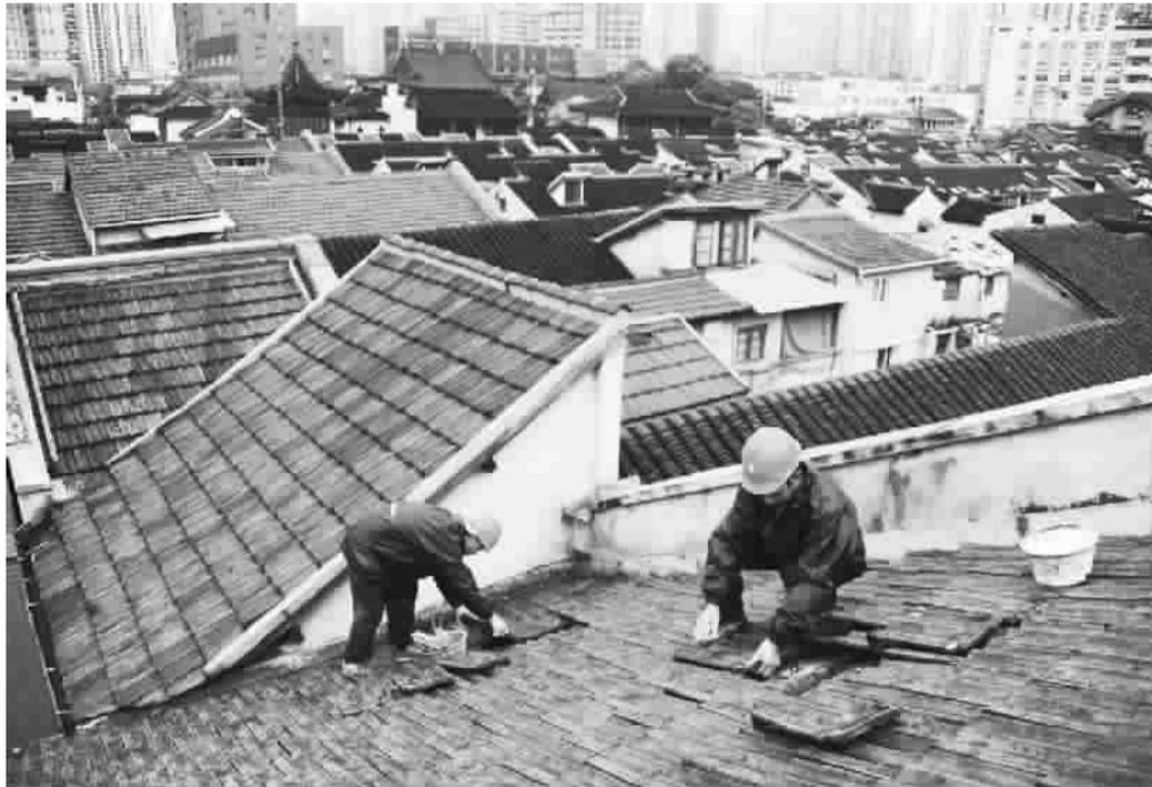
维修人员趁雨停间隙在居民老房屋顶上“筑漏”
