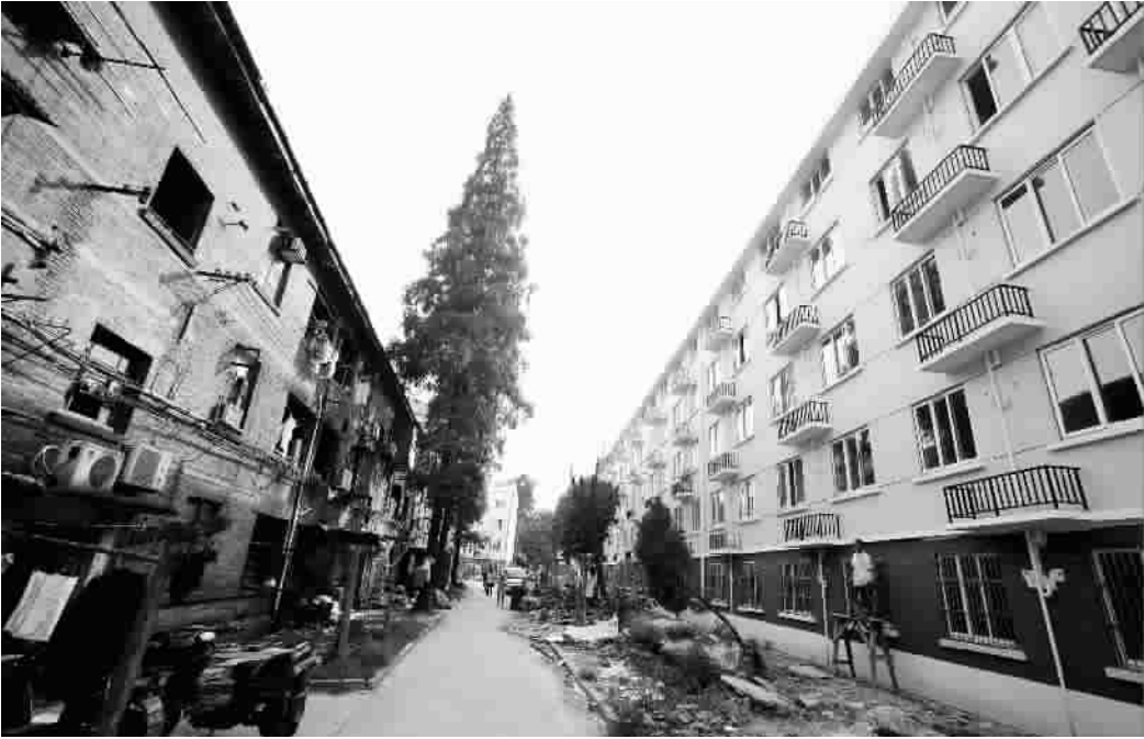
■ 煤卫合用老房(左)和改造好的新房
