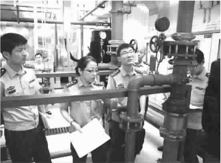
▲▼ 李旻在勘验建筑防火工程
