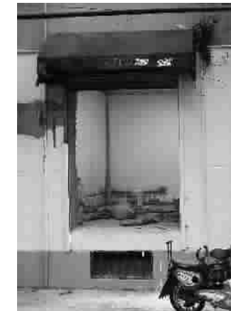
连窗带整面墙被敲 屠仕超 摄
