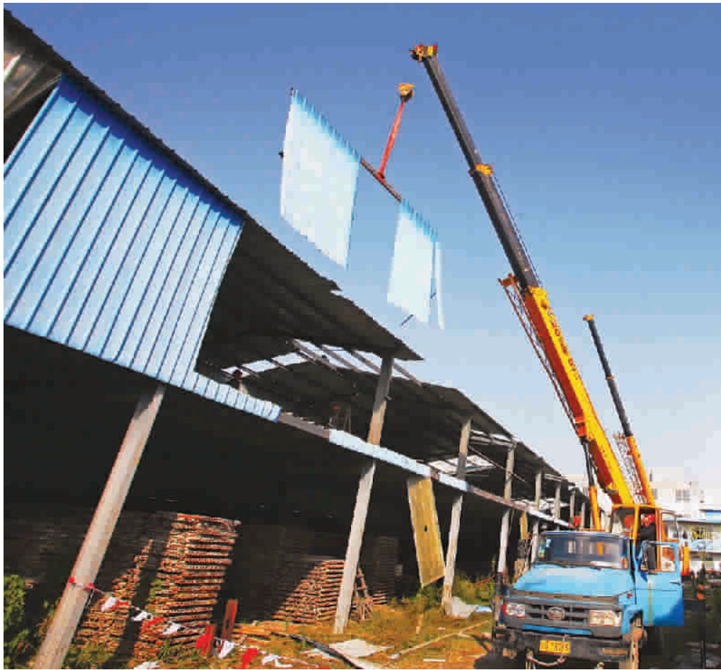
■今天上午9时,许浦村一建筑堆场被拆除
