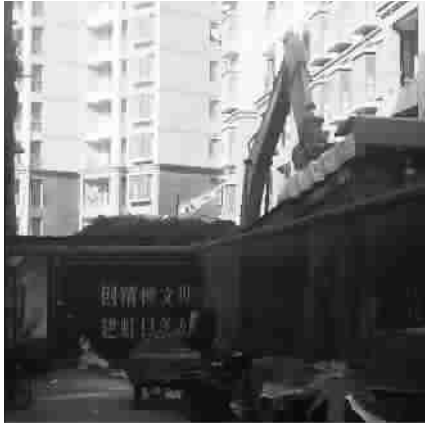
■ 高高的渣土山让居民不安 屠仕超 摄
