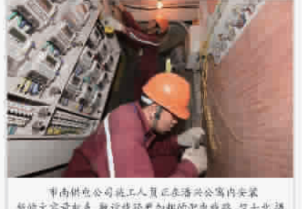
市南供电公司施工人员在居民公寓内安装新的电表，敷设线路更加粗壮的配电线路 赵士北摄
