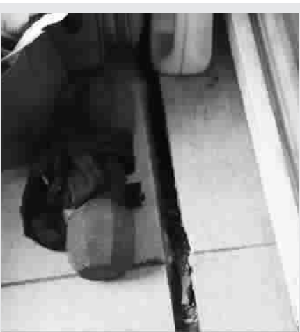
▲ 阳台上地砖缝隙间隔约 3 厘米,因沉降上下地砖高度差约 2~3 厘米 ◀ 窗户与窗台缝隙最严重处间隙约有 4 厘米 陆常青 季晟祯 摄
