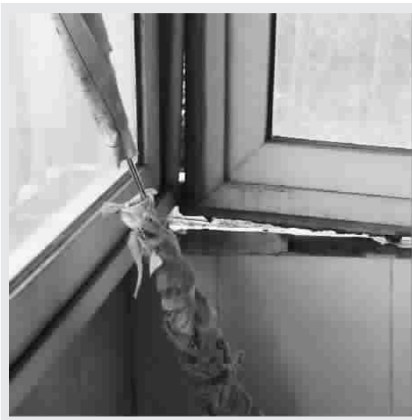
▲ 阳台上地砖缝隙间隔约 3 厘米,因沉降上下地砖高度差约 2~3 厘米 ◀ 窗户与窗台缝隙最严重处间隙约有 4 厘米 陆常青 季晟祯 摄
