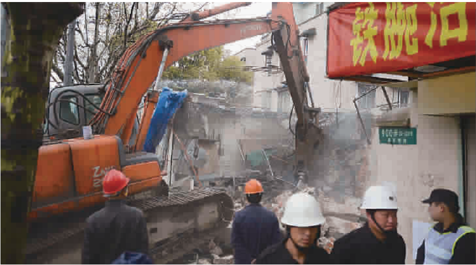
■今天上午,周家嘴路上的违法建筑开始拆除 本报记者 陈梦泽 摄
