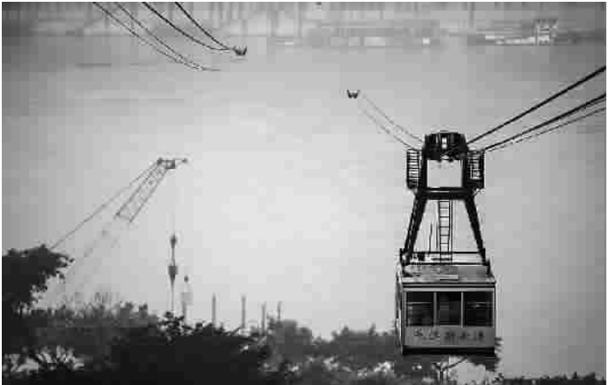
长江索道被称为“万里长江第一空中走廊”
